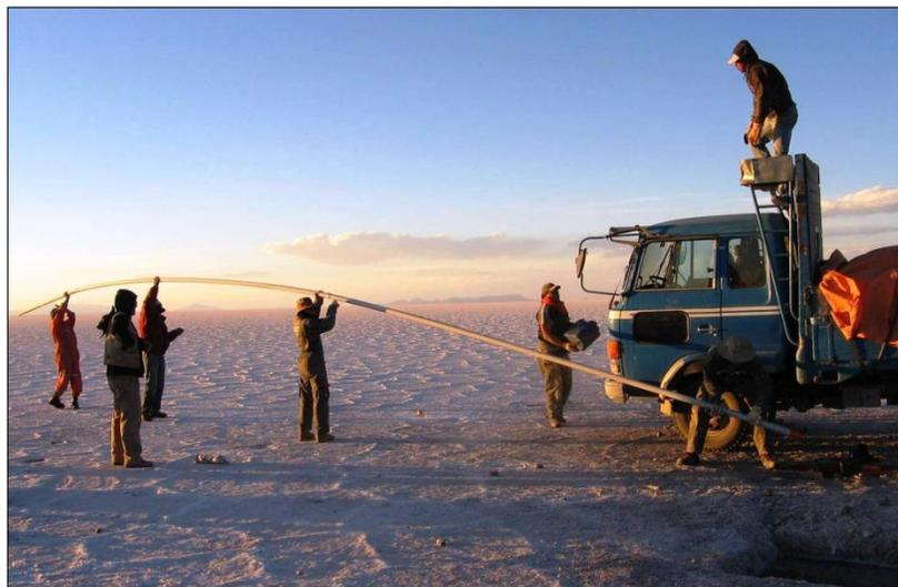
*Fig. 4. Encamisado de Pozos Perforados*
