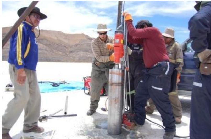
*Fig. 3. Ensanchado de Diámetro de Perforación a 8''*
